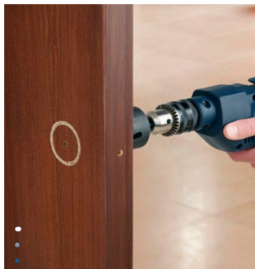
6 Completare il foro da 54 mm dall'altro lato del pannello.
