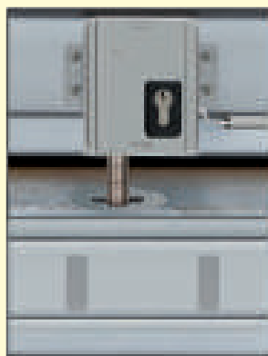
INTERNO/ESTERNO con mezzo cilindro su serranda avvolgibile
